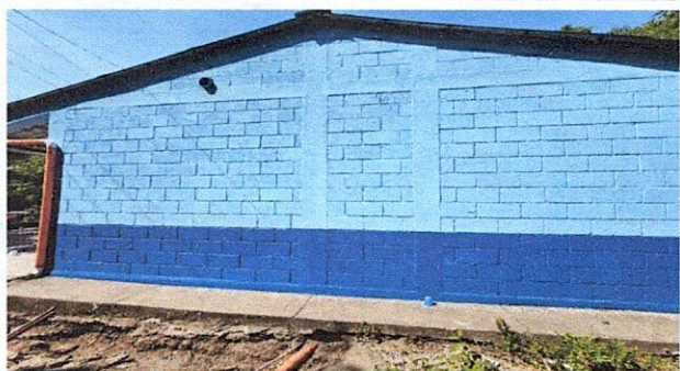
Foto1: Preparación de la superficie y aplicación de pintura a dos manos, en paredes interiores y exteriores del establecimiento.
