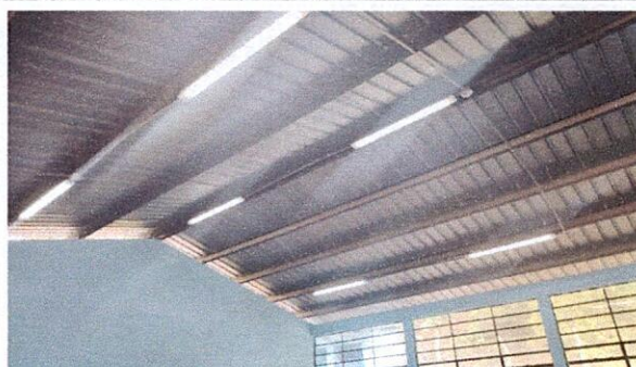
Foto 2: Sustitución de sistemas de iluminación: Lámparas
